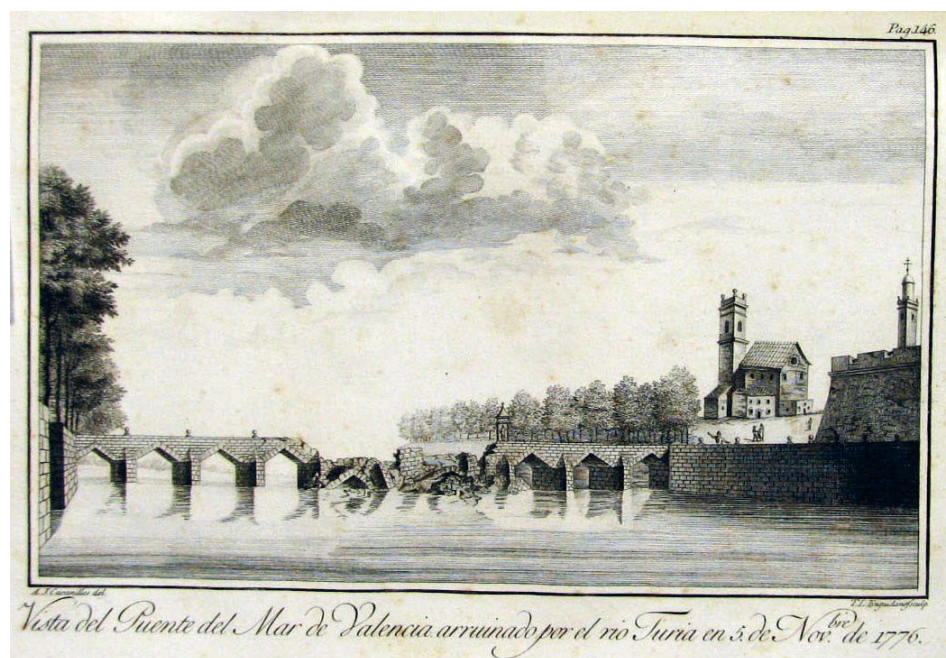
Figura 1. Vista del Pont de la Mar de València arruïnat pel riu Túria el 5 de novembre de 1776
